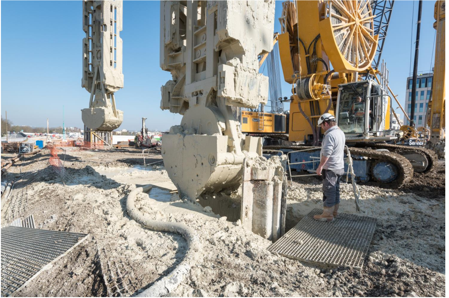
Construction de parois moulées d'une gare du Grand Paris Express
